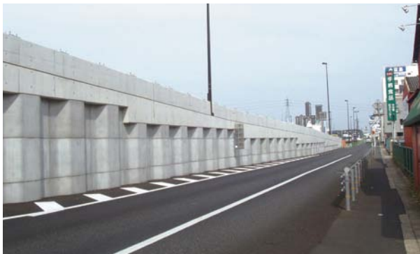
国道2号線 岡山市内立体福富西交差点改良工事 施工場所: 岡山県岡山市
