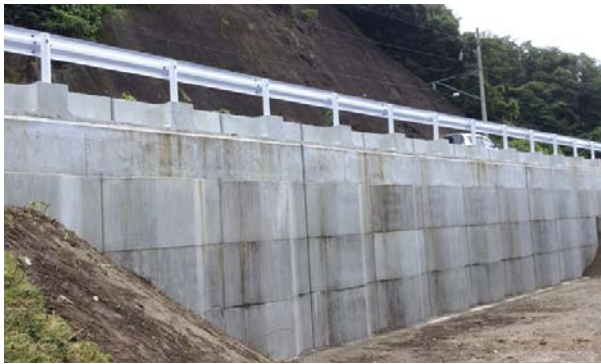
平成27年度 27災2-A02号大張川張外道路災害復旧工事 施工場所: 宮城県伊具郡丸森町
