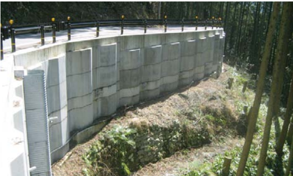
野上清水線小規模道路改良工事 施工場所: 和歌山県有田郡有田川町
