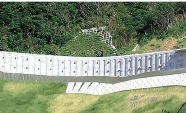
村道阿波連線災害復旧工事(2期) 施工場所: 沖縄県渡嘉敷村
