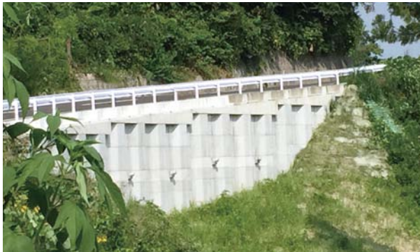
平成26年 災町村第1351号町道白鷺線災害復旧工事 施工場所: 山形県大石町
