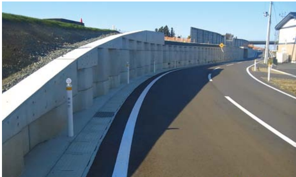
奥州スマートインターチェンジ工事 施工場所: 岩手県奥州市
