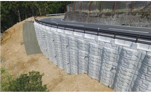
平成26年 査定第7号市道土肥船原峠線道路災害復旧工事 施工場所: 静岡県伊豆市
